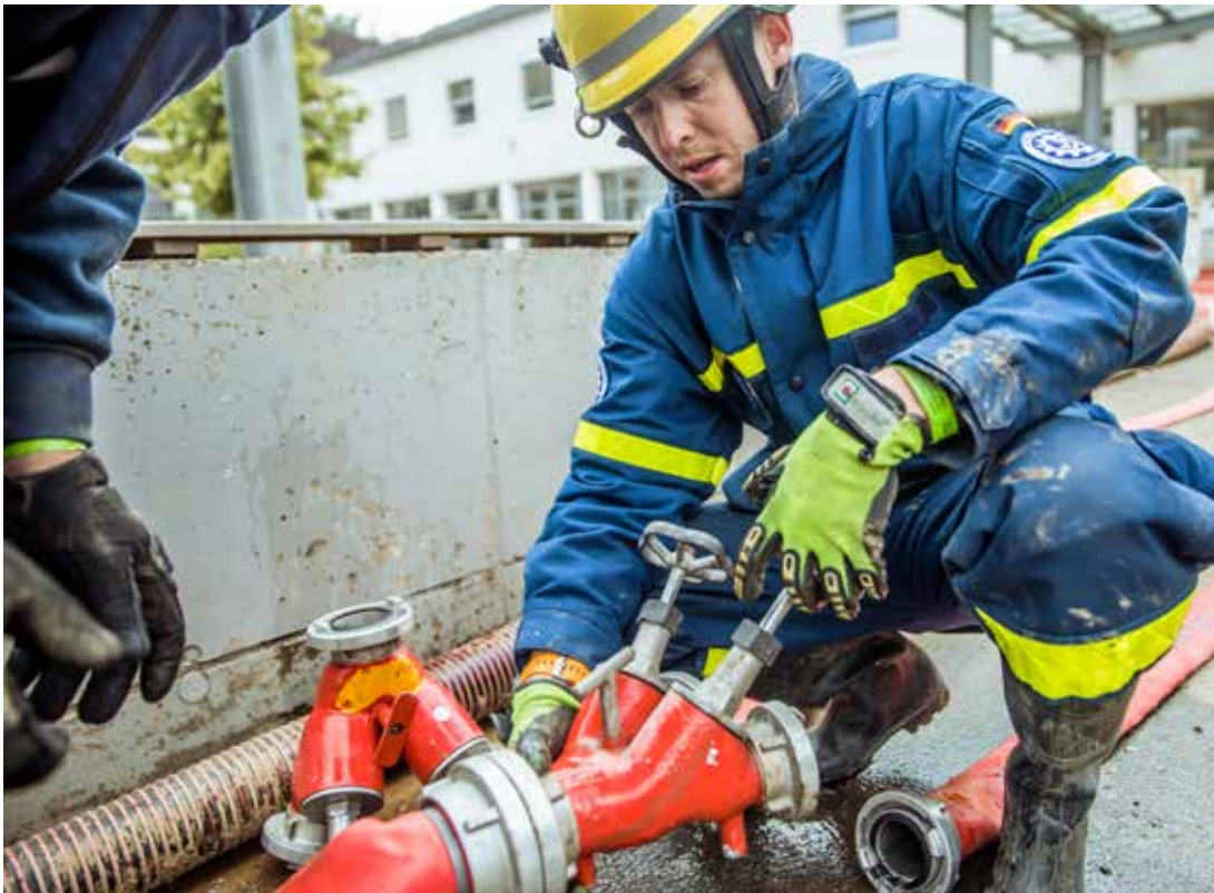
In Bad Neuenahr-Ahrweiler pumpten Kräfte des THW Schlamm aus dem vollgelaufenen Keller eines Gymnasiums. (Quelle: THW/Nicole Endres)
